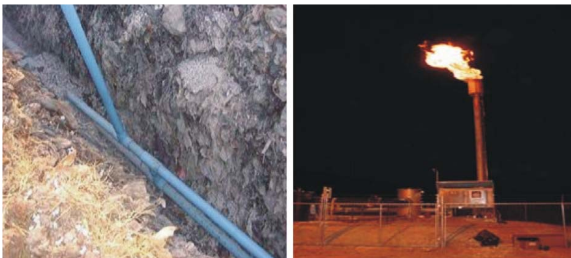
Слика 2 - Систем сакупљања и сагоревања депонијског гаса
