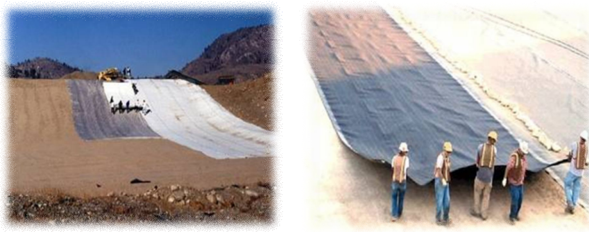
Slika 5.21 Postavljanje donje nepropusne folije
