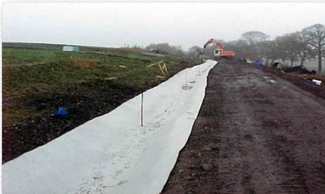
5.19 Prikaz deponije sa obodnim kanalima za oticanje vode sa folije
