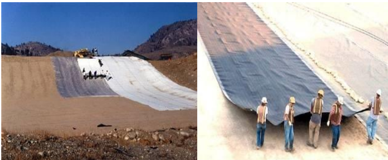
Slika 5.16. Postavljanje donje nepropusne folije.
