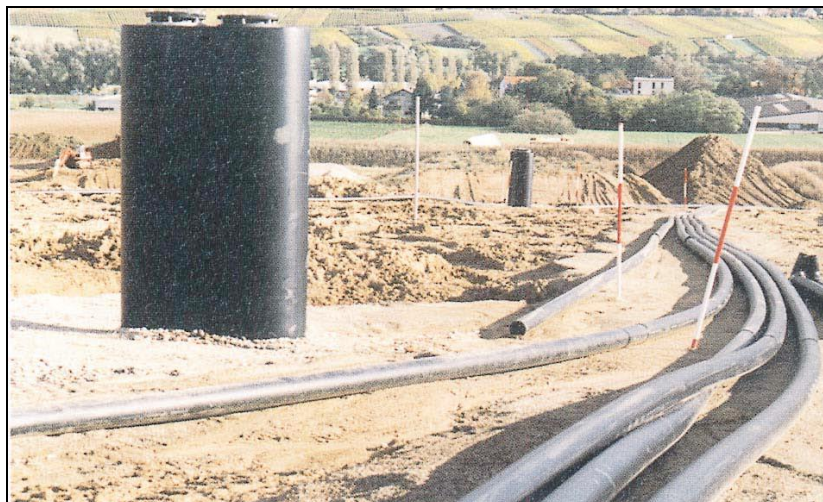
Slika 4.16. Primer sistema za sakupljanje gasa
