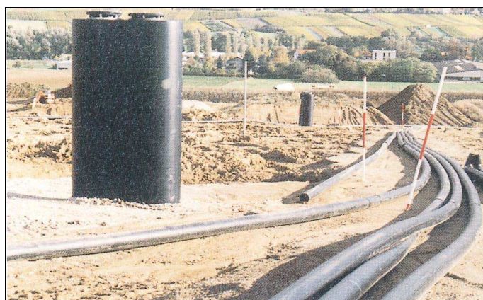
Slika 4.16. Primer sistema za sakupljanje gasa
