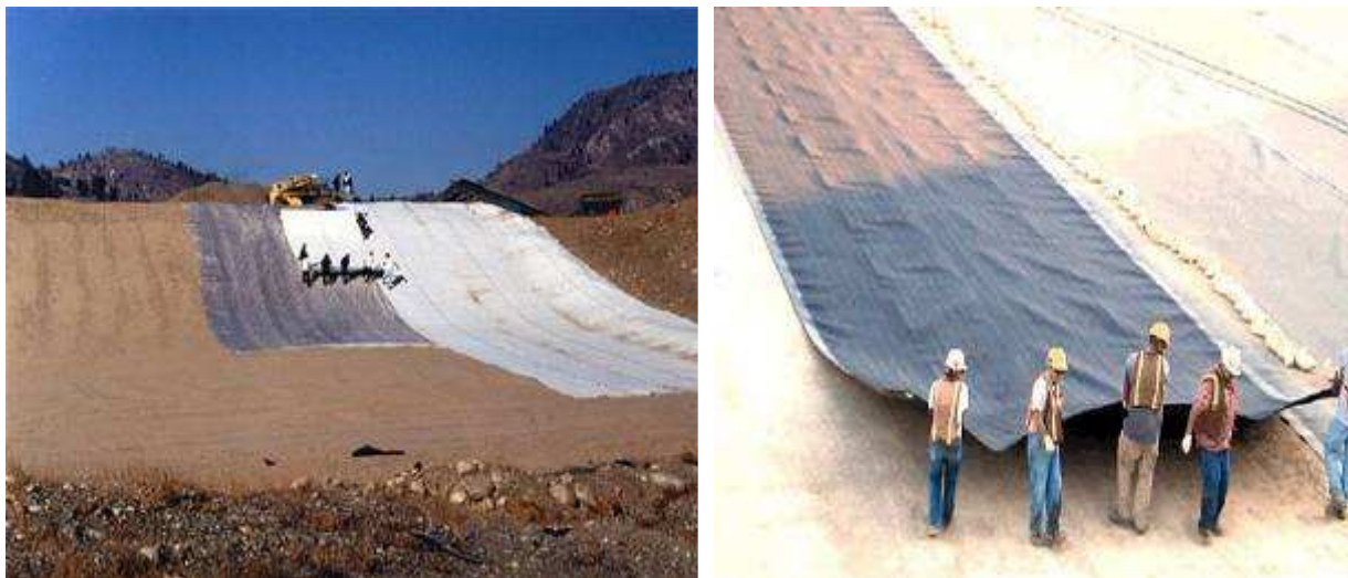
Slika 5.16. Postavljanje donje nepropusne folije.
