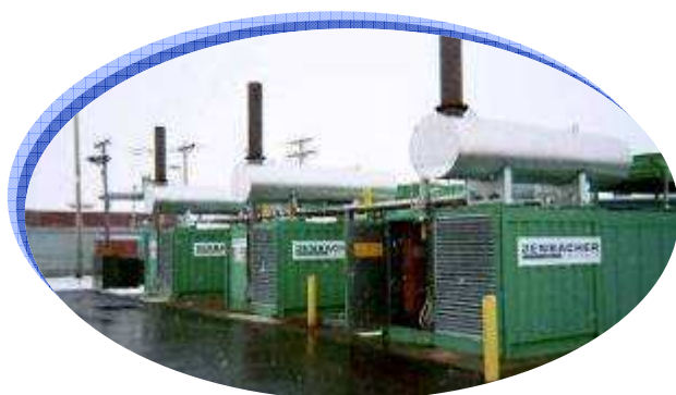
Slika 4.18. Sagorevanje deponijskog gasa
