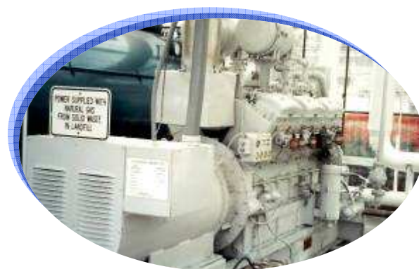
Slika 4.18. Sagorevanje deponijskog gasa
