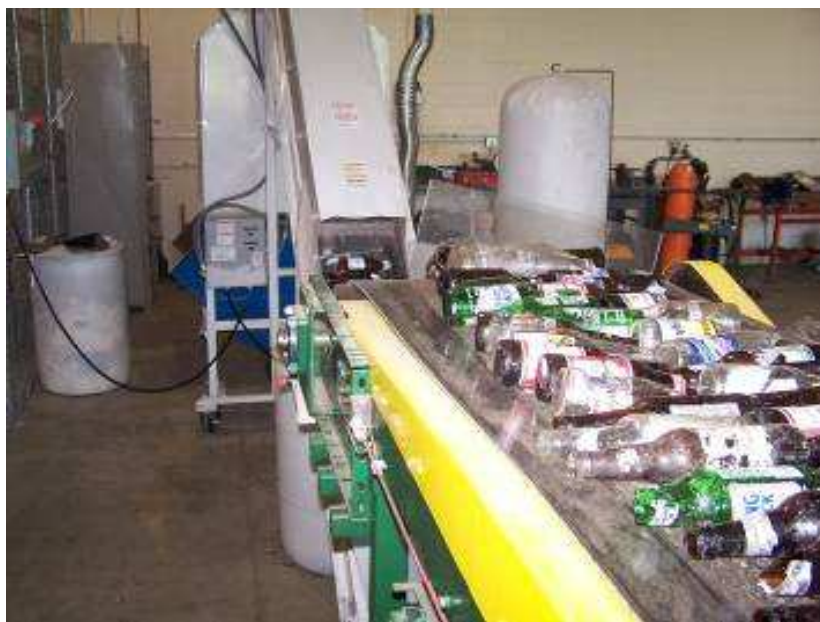
Slika 4.7. Postrojenje za reciklažu stakla
