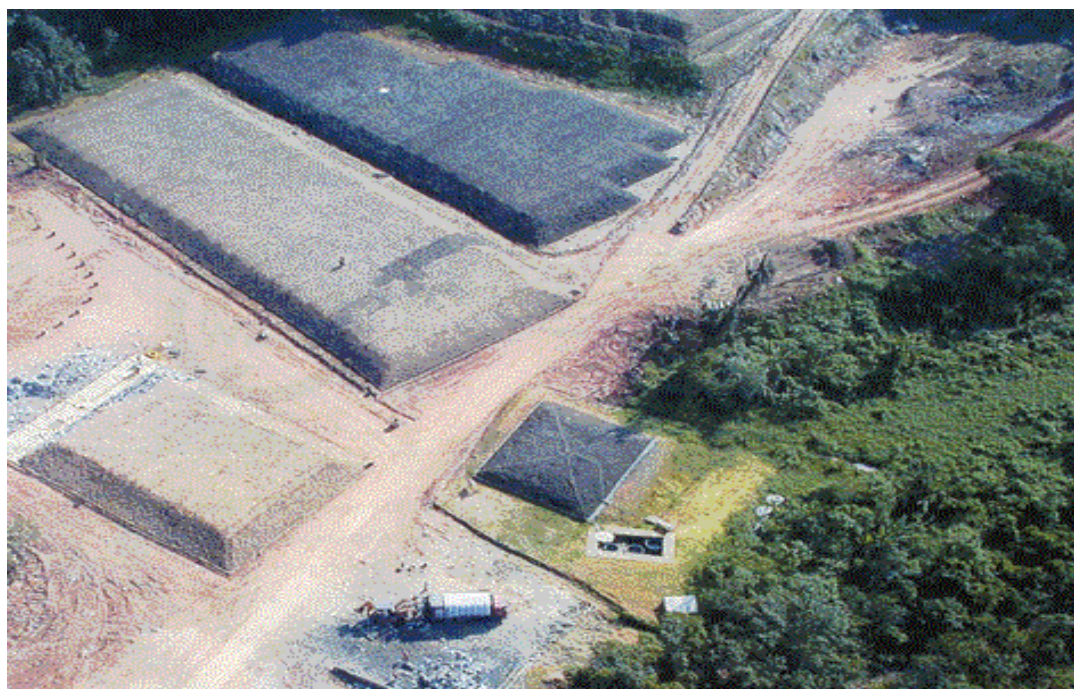
Slika 6.4 Izled MBT lokacije
