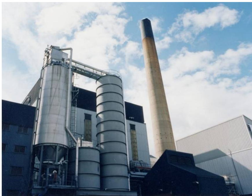
Slika 6.10 Postrojenje za insineraciju
