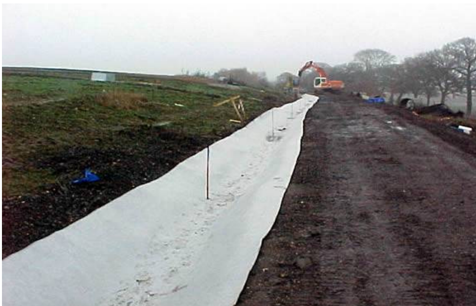
Slika 5.17 Prikaz deponije sa obodnim kanalima za oticanje vode sa folije
