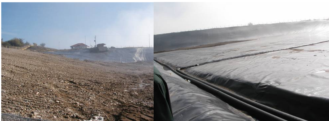
Slika 2.1 Dno deponije i postavljanje folije sa drenažom
