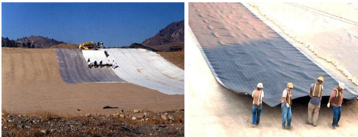
Slika 5.19 Postavljanje donje nepropusne folije
