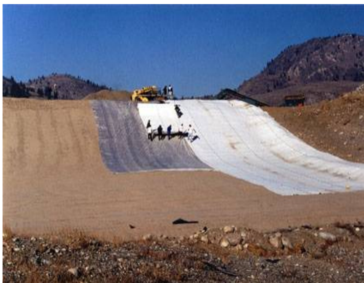
Slika 5.6 Postavljanje geomembrane i geotekstila
