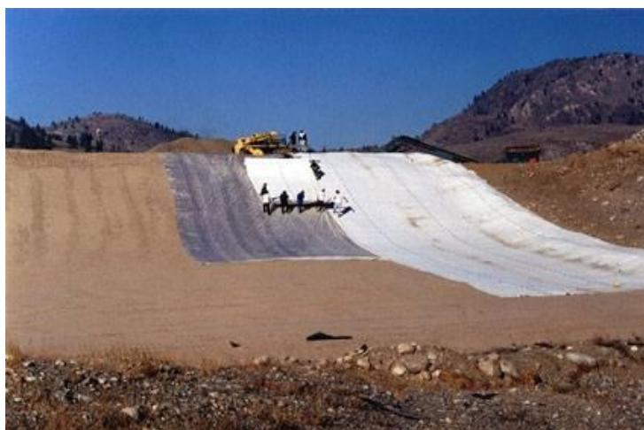
Слика 6.2: Постављање геомембране и геотекстила
