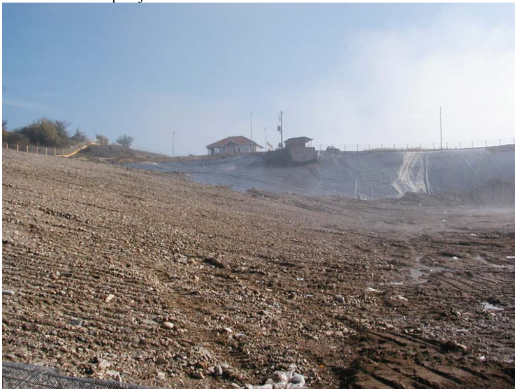
Slika dno deponije sa postavljanjem folije
