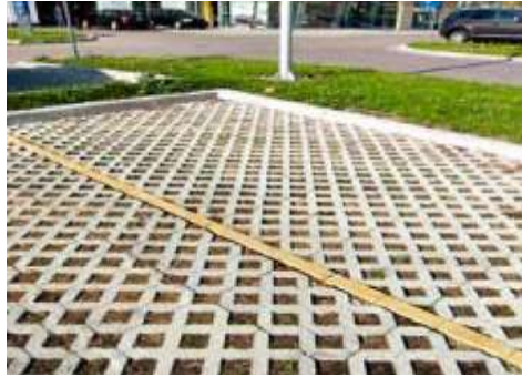
Slika 16. Tipski parking prostor uređen betonskim raster elementima
