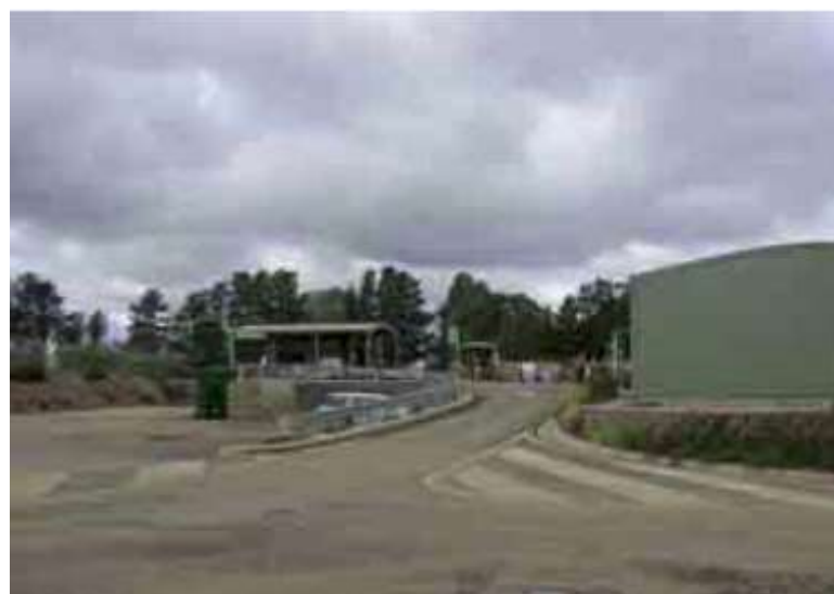
Slika 12. Izgled transfer stanice
