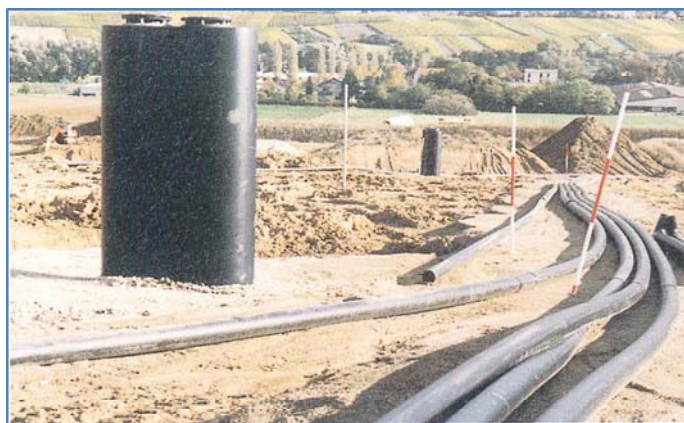
Слика 4.21 Пример система за сакупљање гаса
