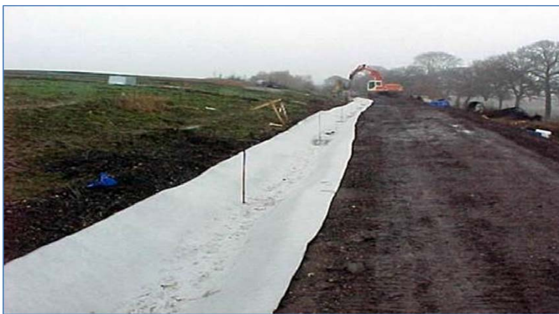
Слика 5.11: Приказ горњих покривних слојева депоније
