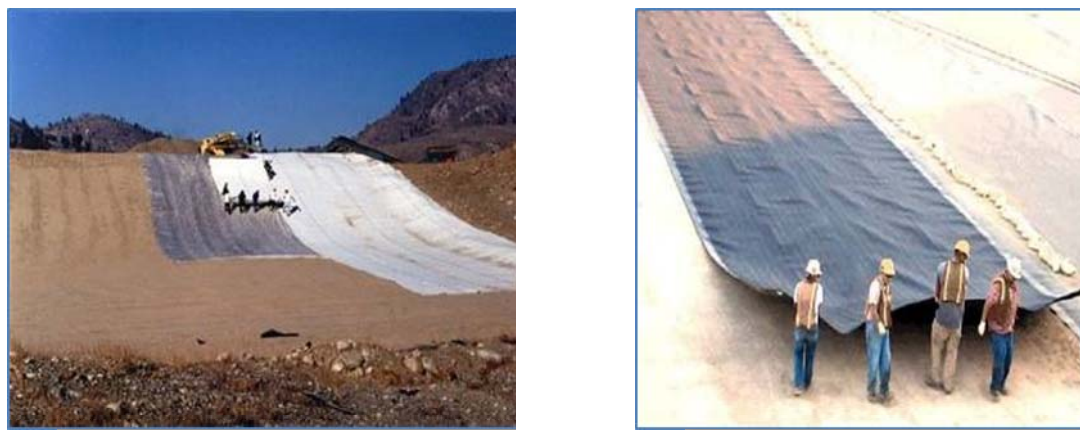
Слика 5.14: Поставања доње непрпусне фолије.
