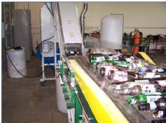
Слика 4.8 Постројење за рециклажу стакла
