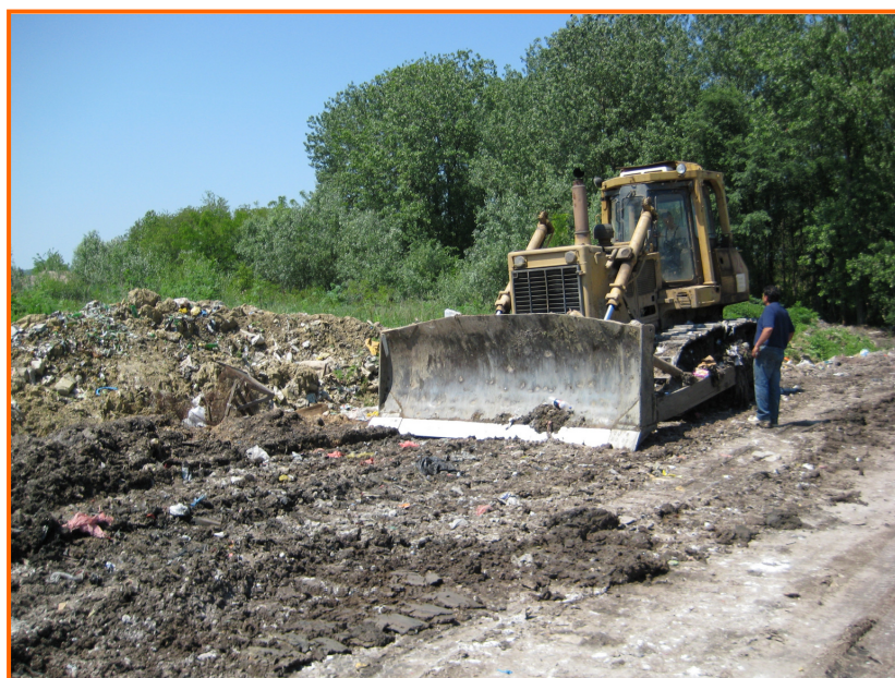
Слика 8. Постојећа депонија комуналног отпада у Барошевцу
