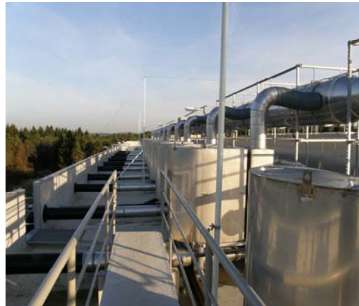
Слика 84 - Изглед постројења за МБО у Цељу, Словенија - капацитет 350.000 ЕС (горе). унутрашњост коморе за обраду отпада (доле лево) и филтери за пречишћавање ваздуха (доле десно)
