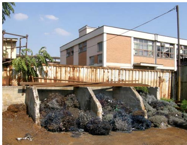
Слика 39 - Привремено складиштење отпада "Rapp Zastava"
