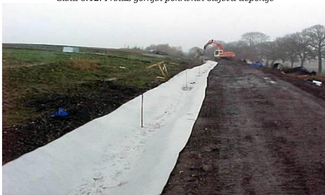
Slika 5.13. Prikaz deponije sa obodnim kanalima za oticanje vode sa folije
