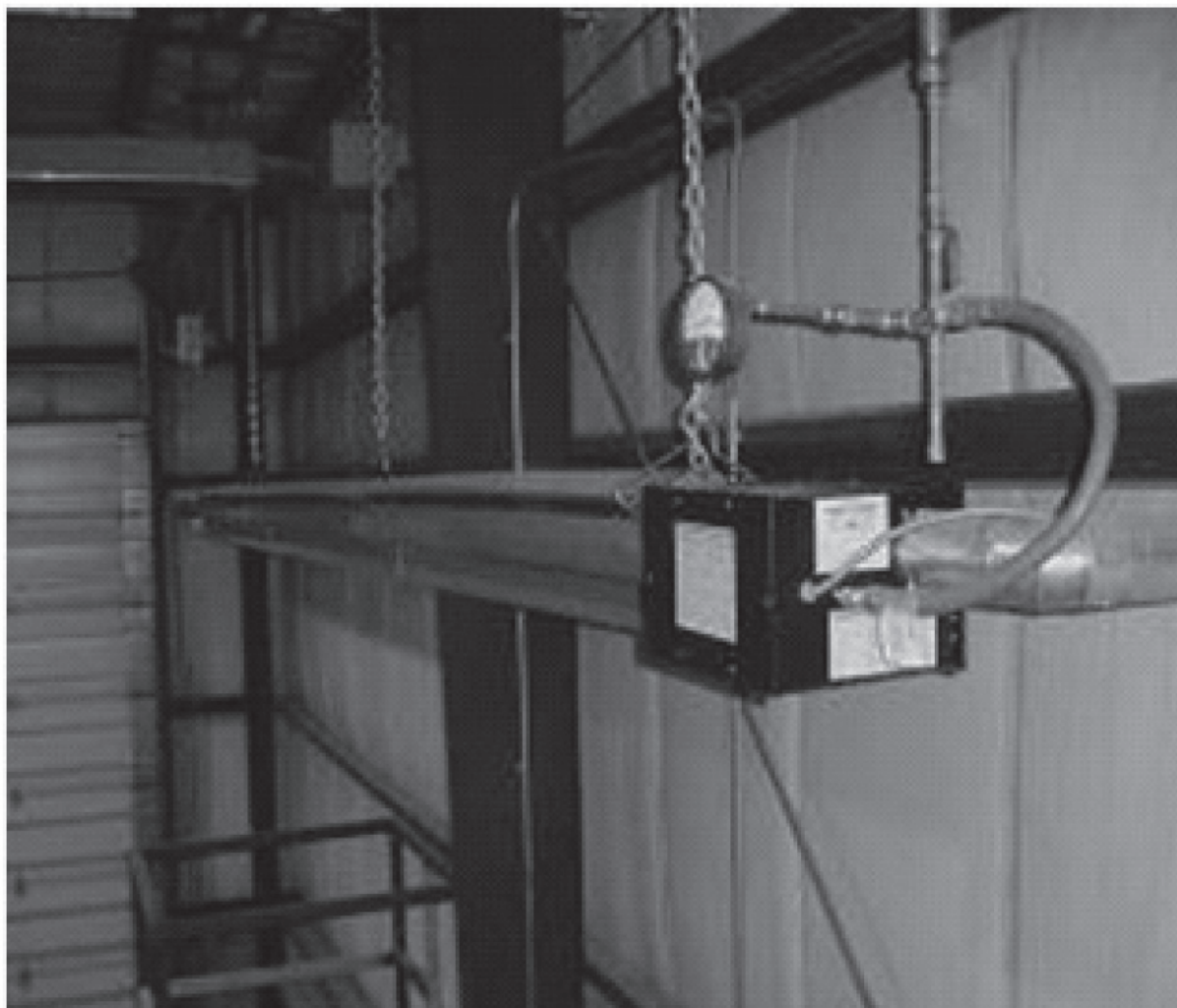
Слика 5.17. Инфрацрвено грејање просторија
