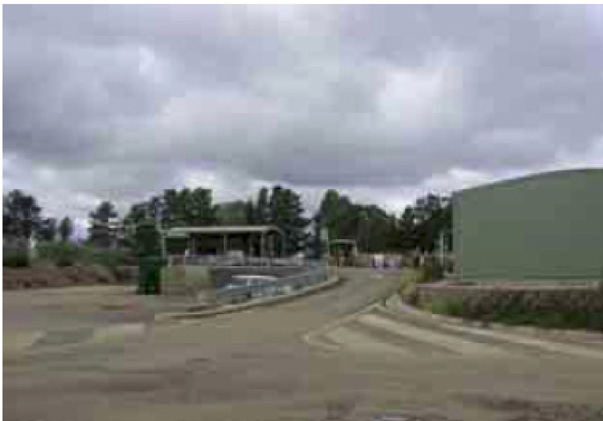
Слика 5.16 Изглед трансфер-станице
