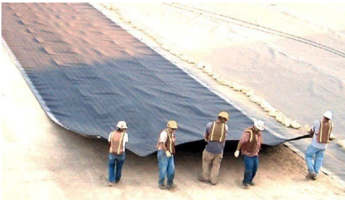
Слика 5.21 Постављања доње непрпусне фолије
